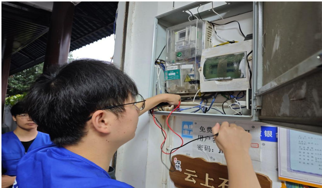
图 3-3 学校社会实践小队在乡村居民点开展电气线路检测
